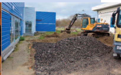
Démarrage des travaux d'aménagement aux abords du dojo.
