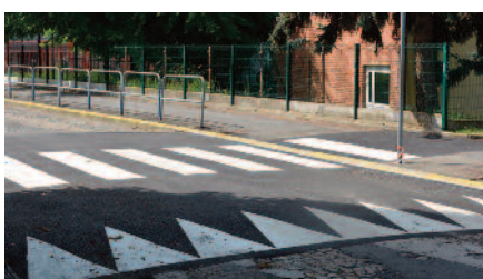
Création d'un plateau surélevé aux normes PMR ainsi que du passage piéton rue Chardavoine à proximité du collège.
