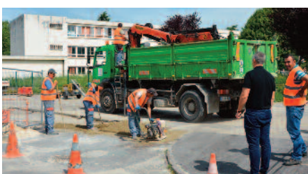
Nouvel accueil de loisirs : travaux préparatoires de dévoiement des réseaux.
