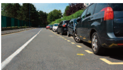
Création de places de stationnement provisoires rue Rabelais pendant toute la durée des travaux.
